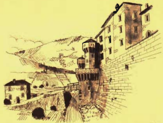
1390. Baluardo di sud ovest. Ponte di legno sulla Reggia e strada per il Borgo Inferiore (San Francesco).
