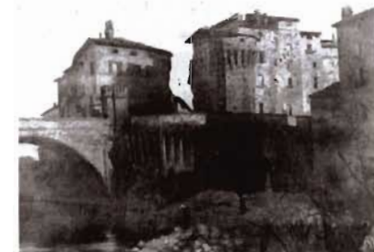
Dipinto propr. Bertanzi. Le torrette di difesa all'inizio del ponte. Al centro, il torrione ottagonale demolito nel 1886 quando fu costruita la ferrovia dell'Appennino Centrale.
