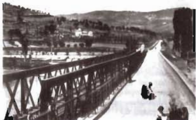
Anno 1906. Il ponte della Ferrovia dell'Appennino collocato sopra i piloni del ponte stradale.
