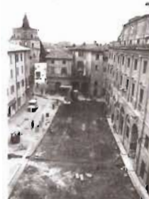
Anno 1984. Lavori di ripavimentazione della piazza.
