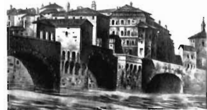
Disegno del ponte sul Tevere pubblicato nell'opera di A. Guerrini (1883). Si notano la chiesetta della Vergine del Carmelo costruita sul pilone e demolita nel 1867, le due torrette all'ingresso del ponte e il torrione a ridosso della casa Bertanzi.
