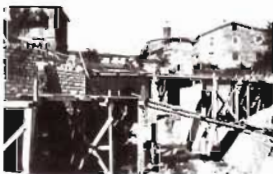
Anno 1934. Costruzione dei ponti sul torrente Reggale per la ferrovia a scartamento normale Umbertide - Sansepolcro.
